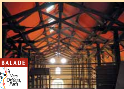
L'impressionnante charpente de l'ancienne halle à charbon restaurée de Grossouvre.
